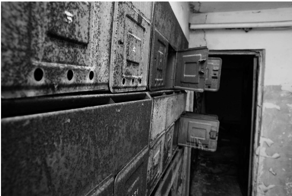
Fot. 9. Klatka schodowa jednego z budynków mieszkalnych w Prypeci.
